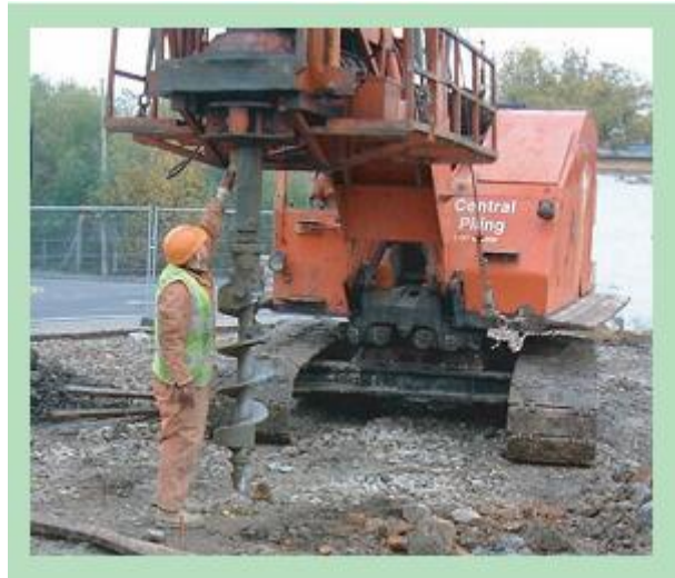
8-rasm. Quyib tayyorlanadigan qoziqlar
