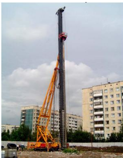
5-rasm. Qoziqni yerga uskunalar yordamida qoqib kiritish
