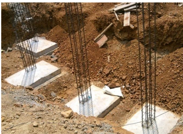
1-rasm. Monolit ustunlar ostiga o'rnatilgan aloxida poydevorlar
