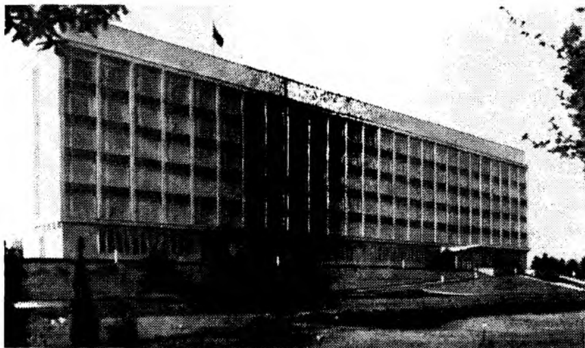
Toshkent. Oʻzbekiston koʻchasidagi maʼmuriy bino, 1964-y. Arxitektorlar A. Fanleyb, V. Berezin, S. Eshonxoʻjayev, Yu. Xaldiyev.
