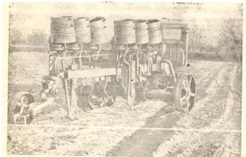
35-расм. ПУ-2—35 маркали тиркама плуг.
