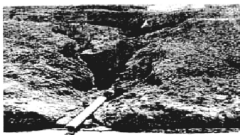
3.2.12-rasm. Oqava suvlarini kollektorga tushirish inshootlarining buzilishi.
