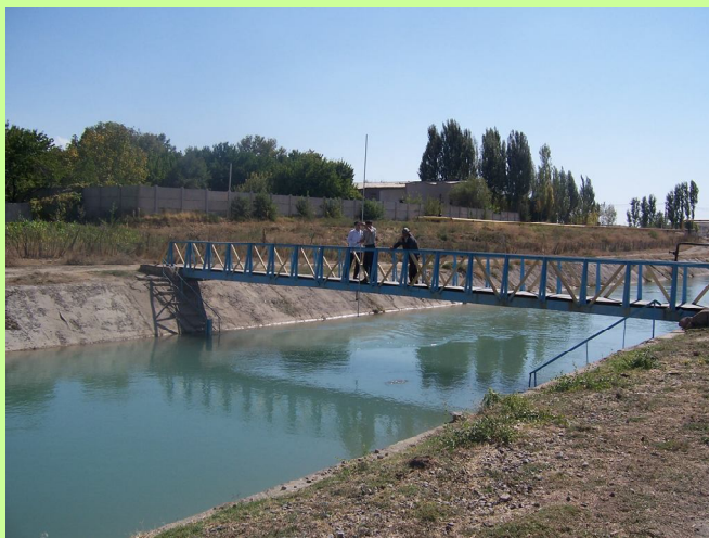
Паркент каналидаги гидропост
