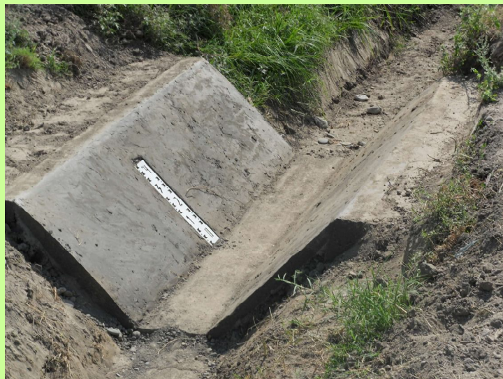
14-rasm. O'zgarmas o'zan turidagi suv o'lchash posti.
