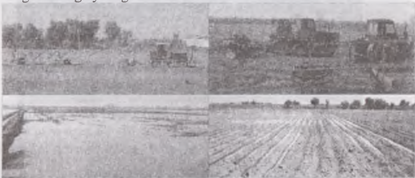
21–rasm. Uzun bazali va molalarda tekislash va sug'orish suvini dala maydonida notekis taqsimlanishiga olib keluvchi notekisliklar.
