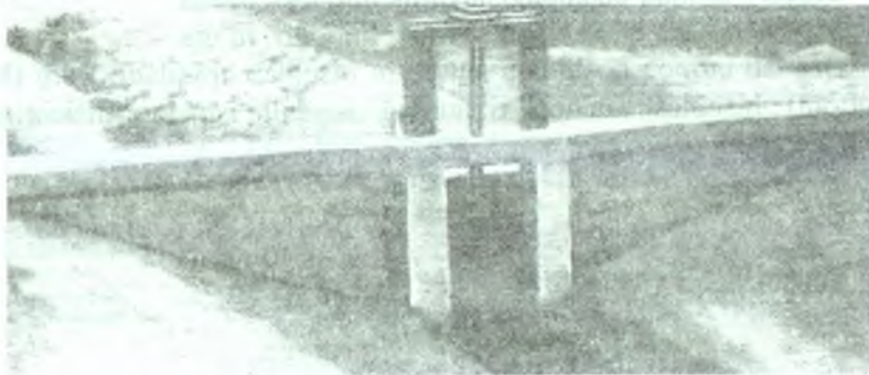
14-rasm. Xo'jalik sug'orish tarmog'idan fermer xo'jaligi uchun suv taqsimlash qurilmasi
