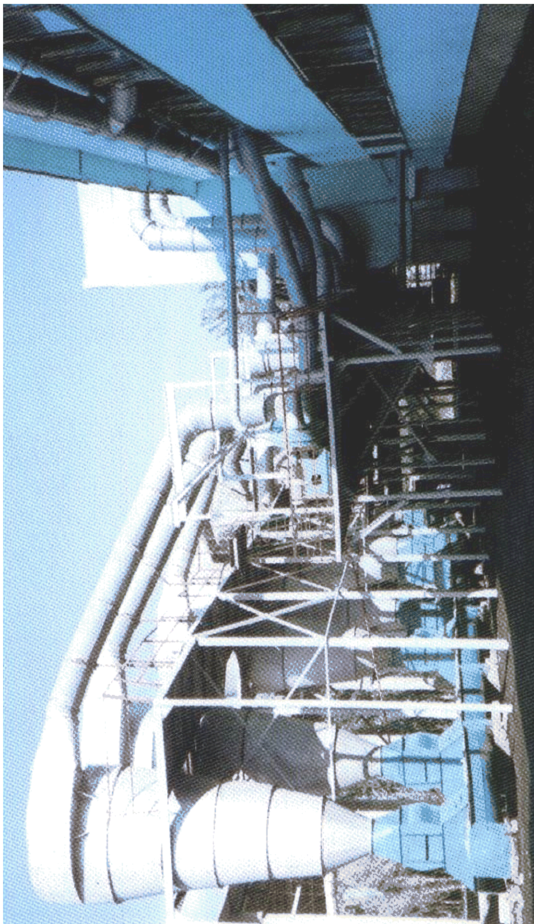
56-rasm. Texnologik uskunalar ishlash jarayonida ajralib chiqadigan changni tutish uchun o'rnatilgan siklon va ventilyatorlar guruhi.
