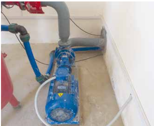
Расм-58. Сув насоси ва сув фильтри
