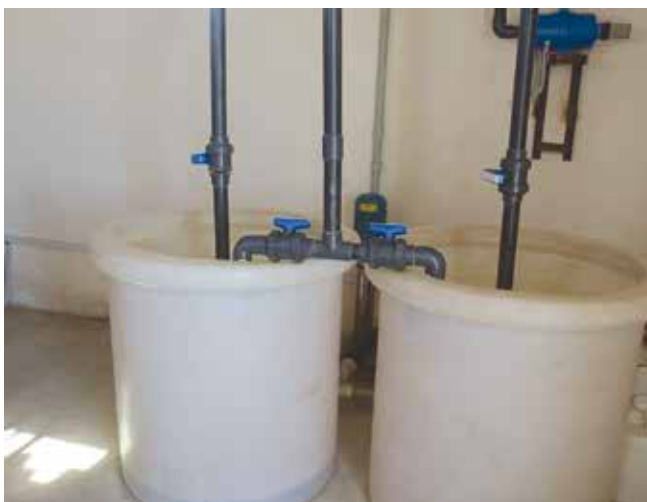
Расм-59. Ўғитловчи мослама ва суғориш тизимни бошқариш учун автомат қурилма.
