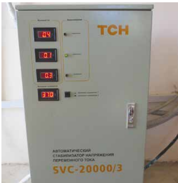
Расм-61. Электр токи доимийлигини таъминловчи қурилма.
