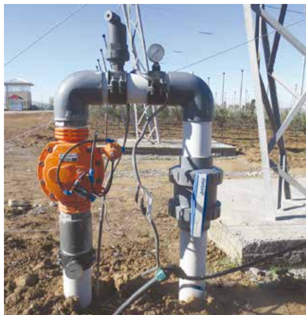
Расм-62. Боғнинг маълум бўлагини суғориш учун кранларни автоматик ёки қўлда очиш маркази.
