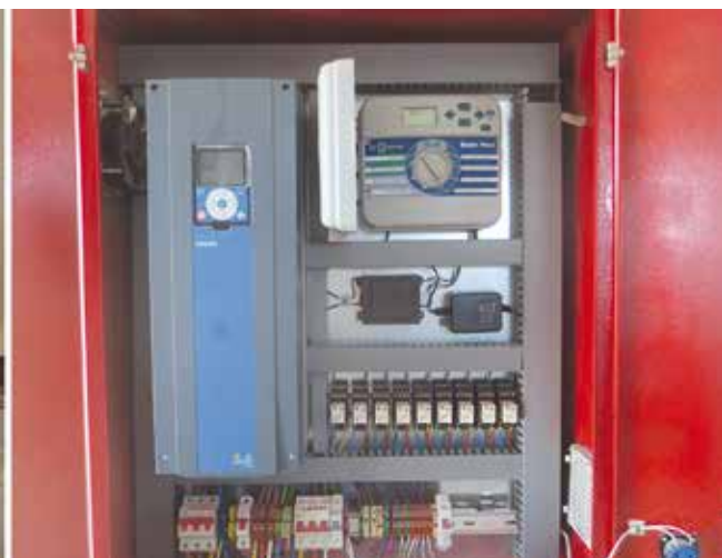
Расм-59. Ўғитловчи мослама ва суғориш тизимни бошқариш учун автомат қурилма.
