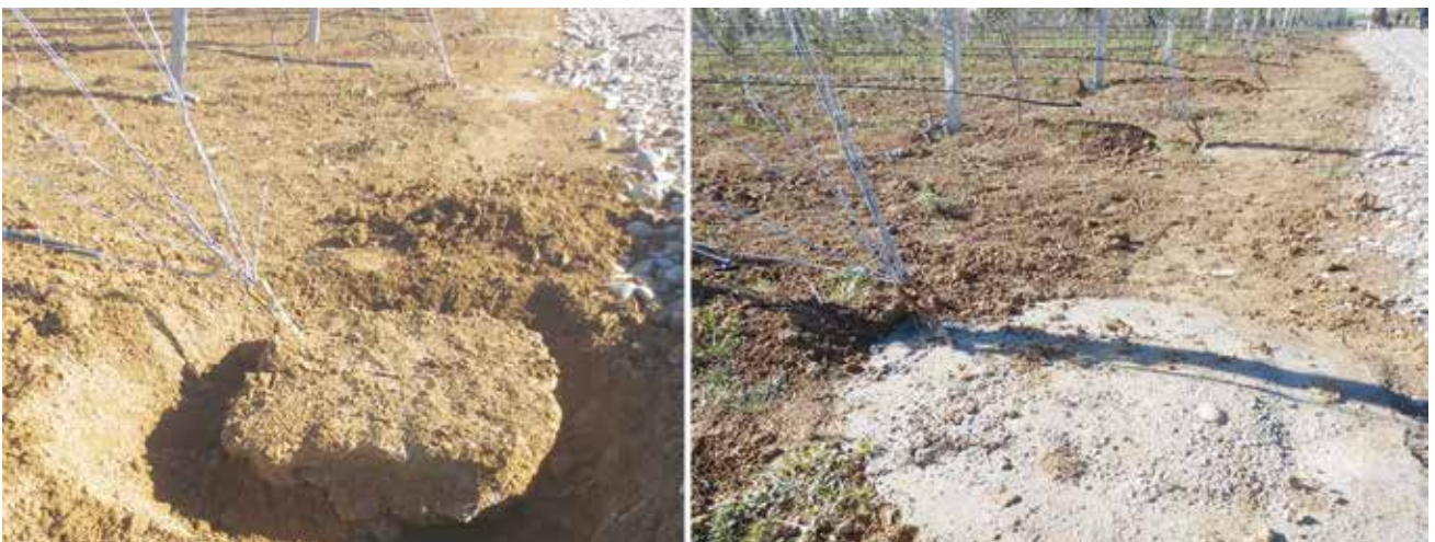
Расм-220. Бутун симбағаз тизимини маҳкам ушлаб туриш учун қатор бошида ереа темир ўрнатилади ва унинг атрофи бетонланади. Чапдаги расмда кам бетонланган қаторда симларнинг таранлиги йўқотилган. Бундай бетонларни ўндаги сингари кенг ва мустаҳкам қуйиш тизимни узоқ муддат хизмат қилишини кафолатлайди.
