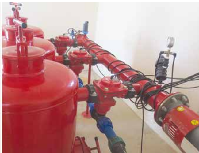
Расм-60. Фильтрларни автомат тозалаш учун бошқарув қурилмаси ва магистрал ва тарқатувчи қувурлар.
