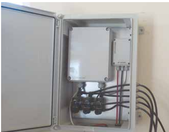
Расм-60. Фильтрларни автомат тозалаш учун бошқарув қурилмаси ва магистрал ва тарқатувчи қувурлар.
