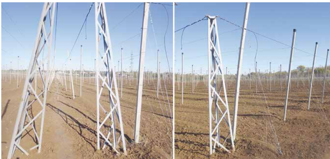
Расм-218. Симбағаз тизимининг мустақамлигини таъминловчи темир ва бетон устунлар.
