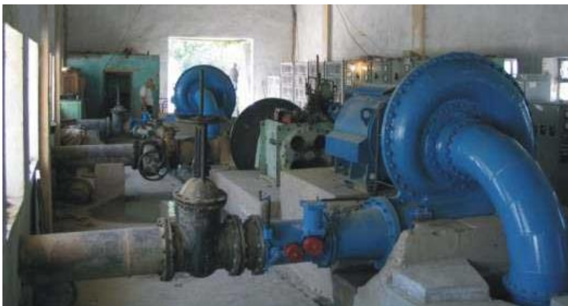
3.11-rasm. Gorizontal radial-o‘qiy turbinalar o‘rnatilgan kichik GES binosining ko‘rinishi.
