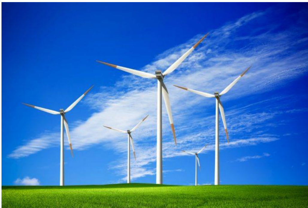
1.2 - rasm. Shamol elektrostansiyasining qir-adirlarda joylashuvi.
