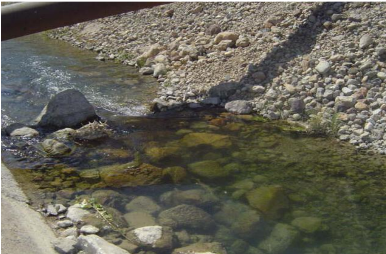
6.3 – расм Тоғ ён бағридан ўтган канал ўзанини тош босиши ҳолати.
