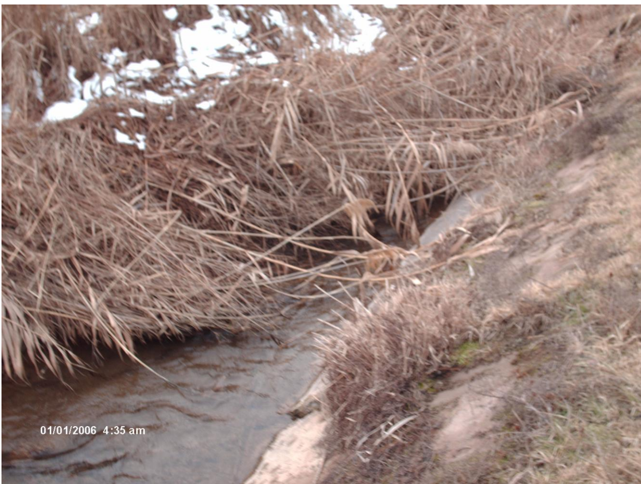
6.2-расм. Бетон каналлар четини ўт босиши
