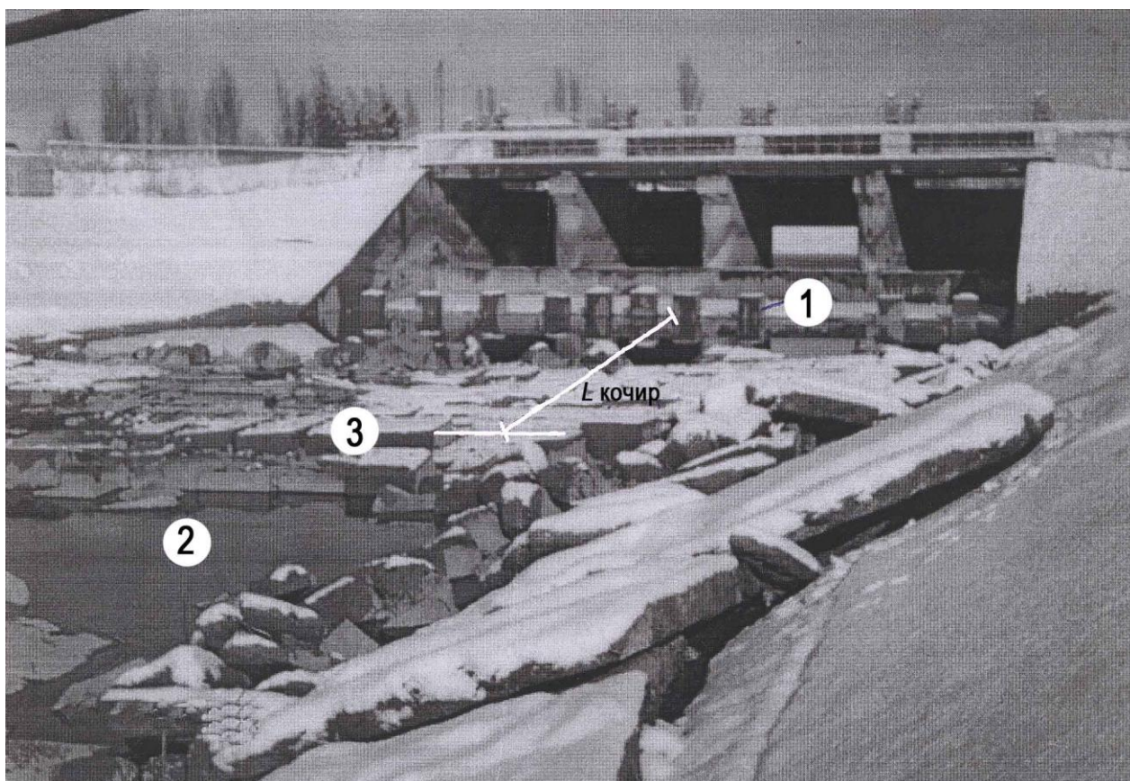
15.17 - расм. Чап қирғоқ Қорасув канали 9+20 пикетидаги сув тақсимлаш иншоотининг Қорасув дарёсига сув ташламаси пастки бьефини кўриниши: 1 - пирслар; 2 - ювилиш даганаги; 3 - фундамент блоклари.
