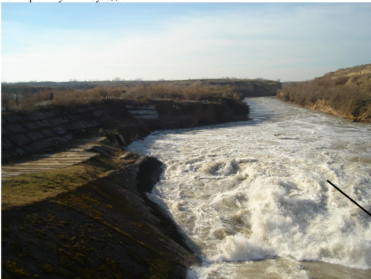
15.18 - расм. Қийшиқ гидравлик сакраш оқибатида иншоот пастки бьефини ювилиши.
