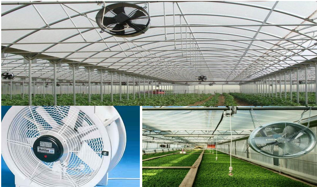
1-rasm. Himoyalangan yerlarda havo namligini shamollatgichlar yordamida rostdash
