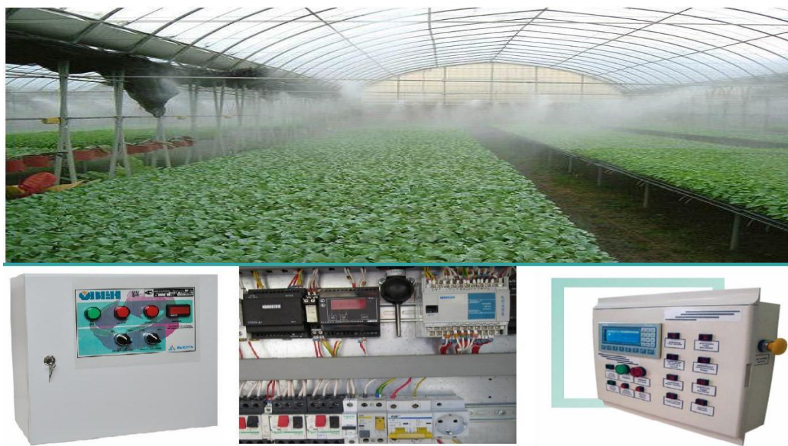
1-rasm. Issiqxonada namlikni rostdash avtomatlashtirilgan tizimi
