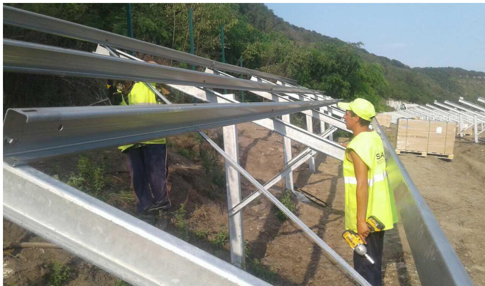
64-rasm. Quyosh fotoelektrik stansiyasining karkas qismini oʻrnatish
