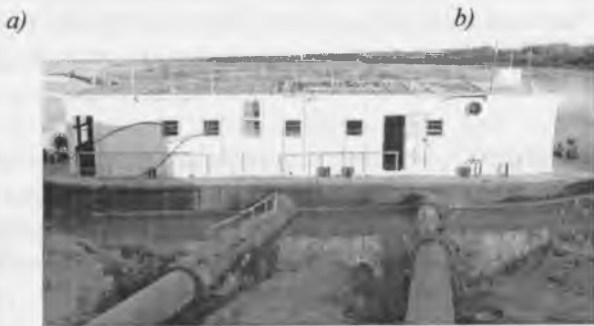
26.2.4-rasm. Nasos stansiyalari: a – doimiy; b – suzib turuvchi.
