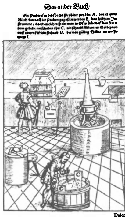
Пробирная лаборатория, в которой исследовали содержание золота и серебра в рудах (из книги Л. Эркера «Описание всех известных минеральных руд»)
