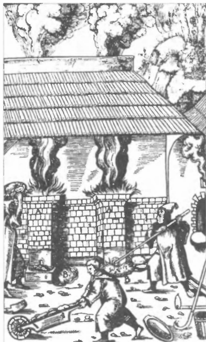
Плавильные печи с передним горном (из книги Г. Бауэра (Агриколы) «О горном деле и металлургии»). Базель, 1556
