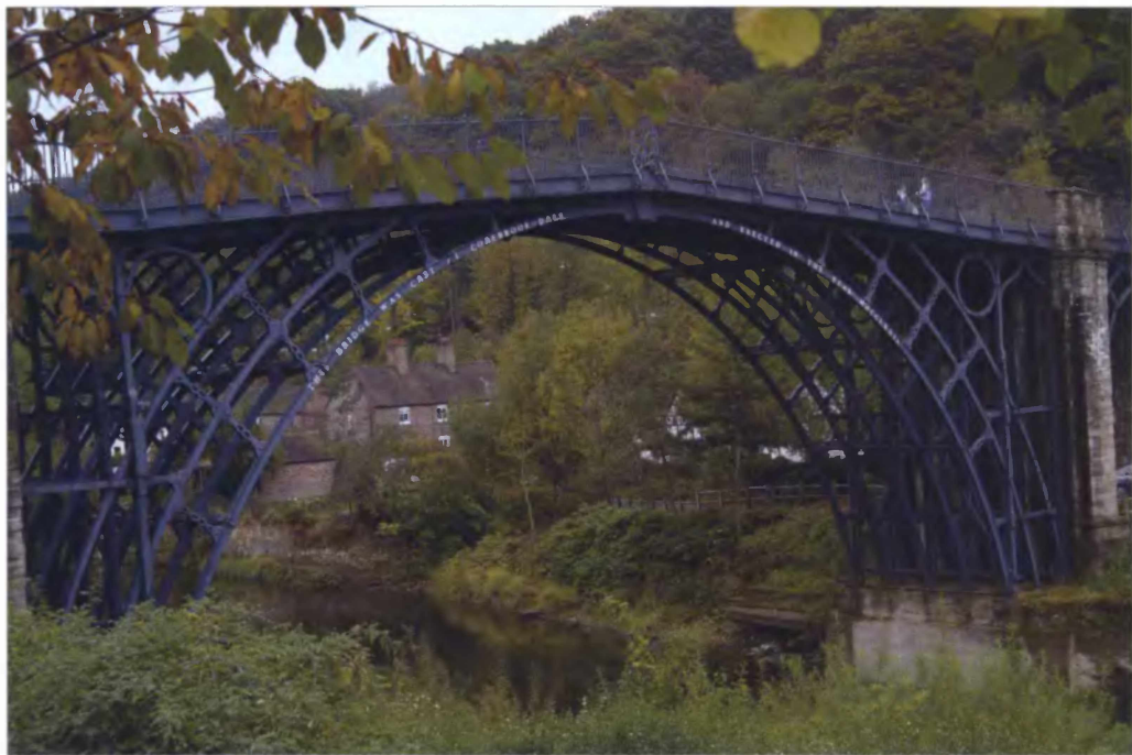
Первый в мире мост, построенный из литых чугунных деталей английским металлургом Абрахамом Дарби III в 1779 г. через р. Северн в местечке Коулбрукдейл (Великобритания). Современный вид
