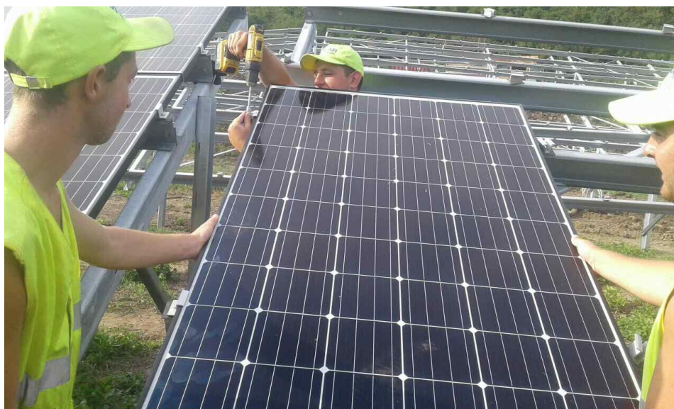
48-расм. Қуёш фотоэлектрик станциясида қуёш панелларини муҳандислар томонидан ўрнатиш
