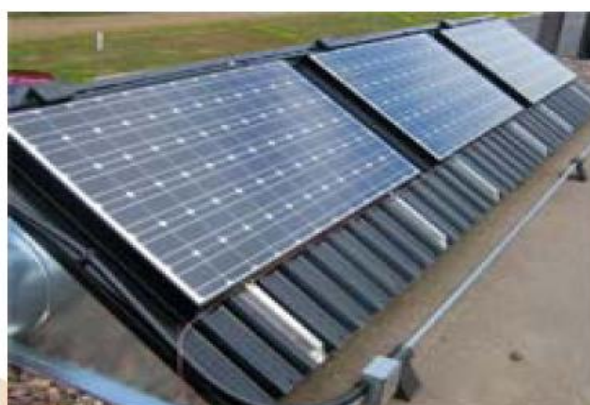
61, 62-расмлар. SolarWall компанияси томонидан яратилган ҳаво фотоиссиқлик қурилмалари
