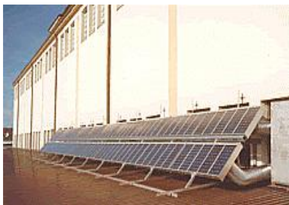
61, 62-расмлар. SolarWall компанияси томонидан яратилган ҳаво фотоиссиқлик қурилмалари
