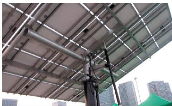
50-расм. Икки ўқли трекерга эга қуёш фотоэлектрик станцияси
