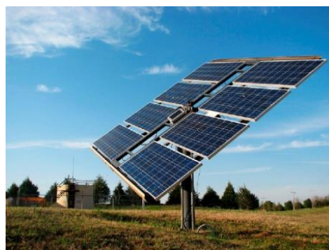
50-расм. Икки ўқли трекерга эга қуёш фотоэлектрик станцияси
