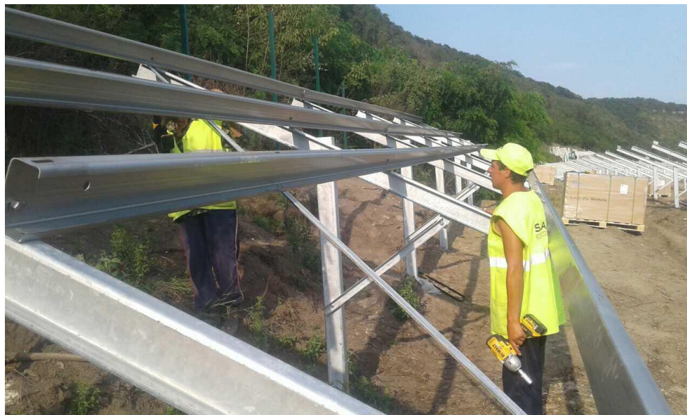
47-расм. Қуёш фотоэлектрик станциясининг каркас қисмини ўрнатиш
