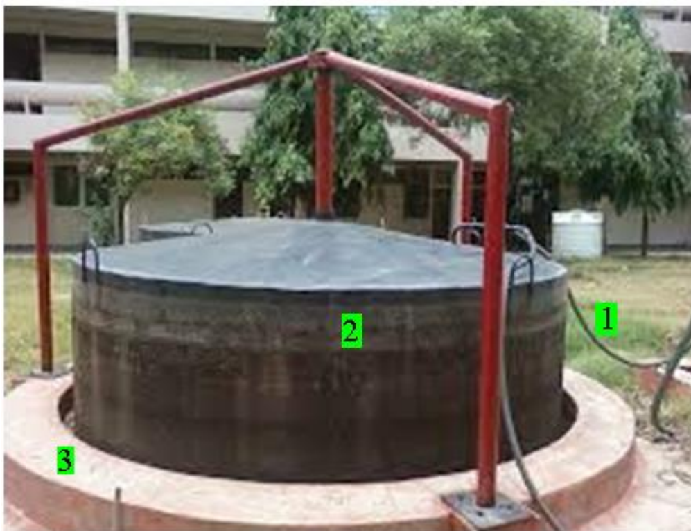
6.5-расм. Газ каллаги сузиб юрвчи биогаз олиш қурилмаси: 1- газ қувури;2-газ каллаги; 3- биореактор
