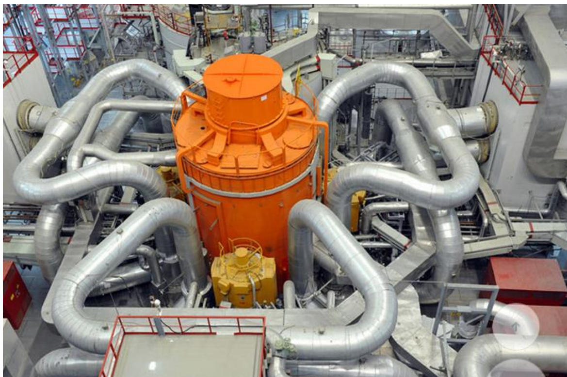
2.1 – расм. Россия дизайнида қурилган БН-800 ("тез натрий") маркали тез нейтронли натрийли иссиқлик ташувчили 4 –энергоблок
