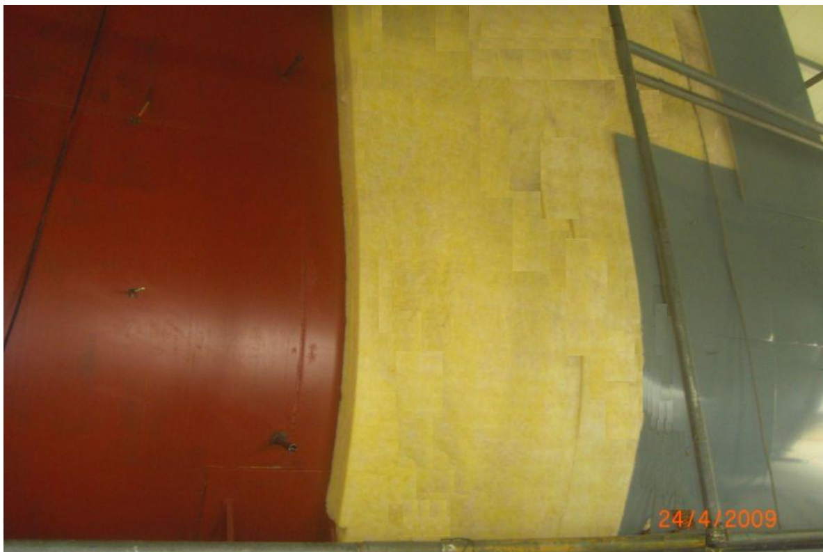
6.19 - расм. Биореакторни қалинлиги 100 мм ли ойна пахтасида “СЕНДВИЧ” типиди иссиқлик ҳимоя ўрамаси билан ўраш.
