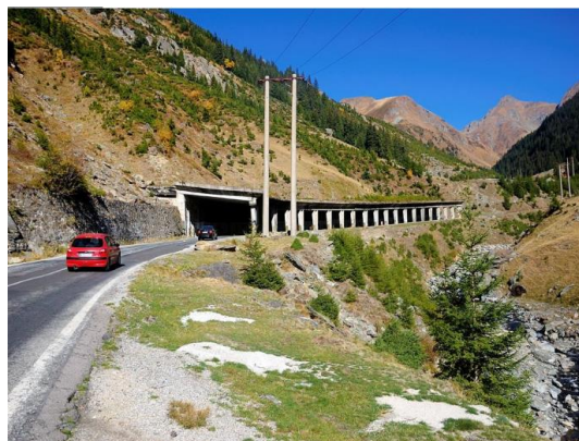
Рис. 3. Установленные противооползневые сооружения А-373 на перевале «Камчик» автодороги «Ташкент-Ош» и строительство специальных галерей для обеспечения безопасности движения на участках, подверженных оползням.
