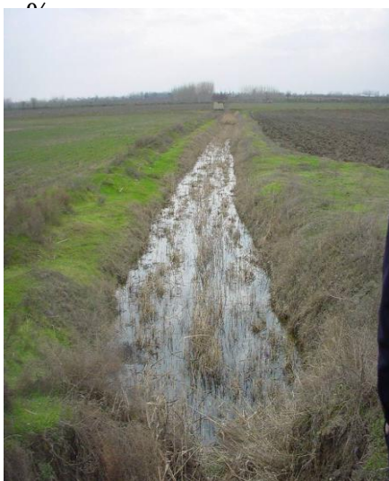
Foto 3. Ishlamaydigan kollektor
