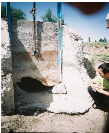
Foto 8.. Suv o'tkazgich shchitning nochor x'olati
