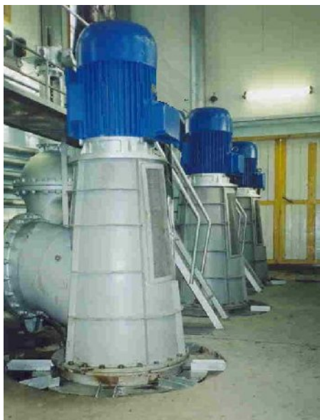
37-rasm. To‘g‘ri o‘qli konussimon ( a ) va tirsaksimon ( b ) so‘rib ketish quvurli parrakli gidroagregatlar.
