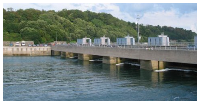
14-rasm. Suv sathning ko‘tarilib-tushish prinsipi asosida ishlaydigan eng katta gidroelektrostansiya.
