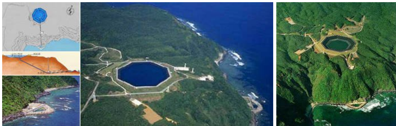
81-rasm. Dengizdan yuqorida joylashgan hajmning suvga to‘ldirilishi va suvni qayta tashlab elektroenergiya olish.
