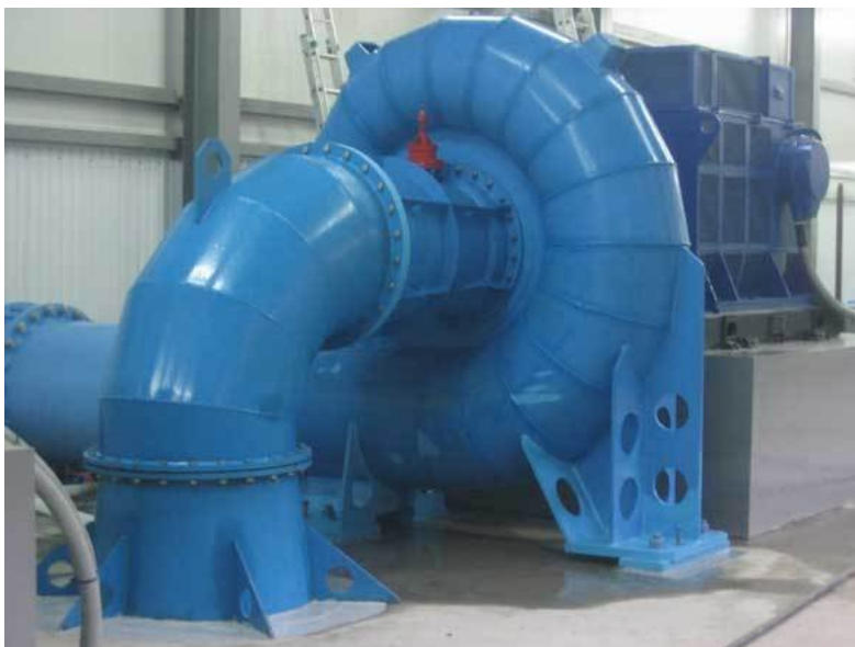
37-rasm. To‘g‘ri o‘qli konussimon ( a ) va tirsaksimon ( b ) so‘rib ketish quvurli parrakli gidroagregatlar.
