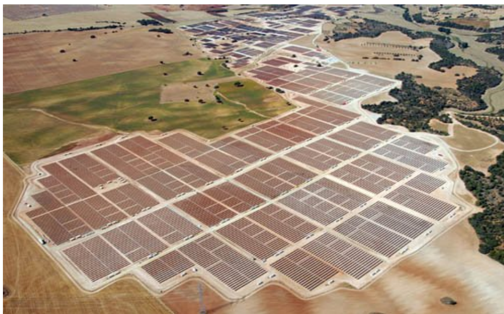
18-rasm. Dunyodagi eng katta fotoelektrik elektrostansiyasi.
