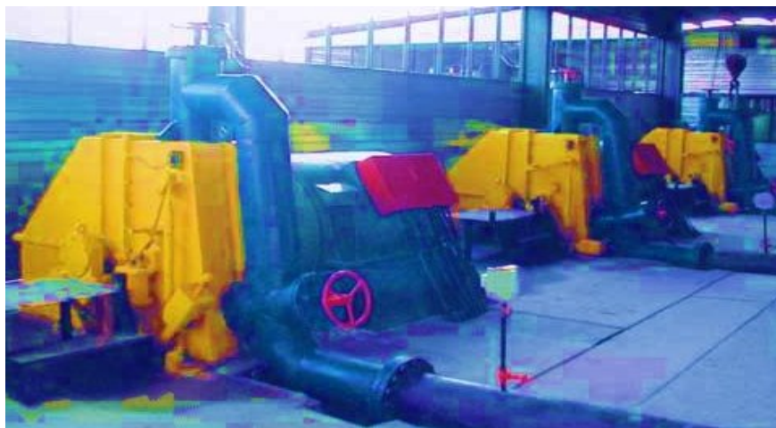
46-rasm. Vertikal o'rnatilgan cho'michli ish g'ildirakli kichik GES mashina zalining ko'rinishi.
