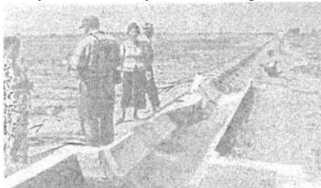
22-rasm. Beton novlardan o'qariq va egatlarga suv taqsimlash jarayoni
